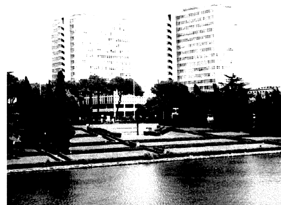
CON VISTA SUL LAGHETTO Due delle alte Torri dell'Eur: per molti anni sono state la sede del Ministero delle Finanze
